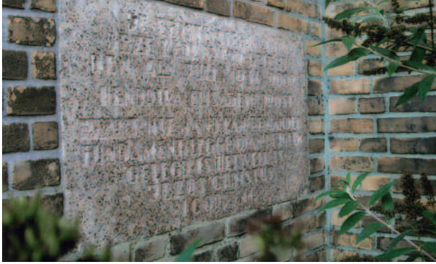
Afb. 2 De eerste steen ingemetseld aan de buitenzijde, rechts van het toegangsportaal.
