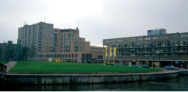
Afb. 2 Een gezicht op het gerenoveerde en het nieuwe deel van het woonwinkelcentrum 'Lange Voort' (foto van de auteur).
