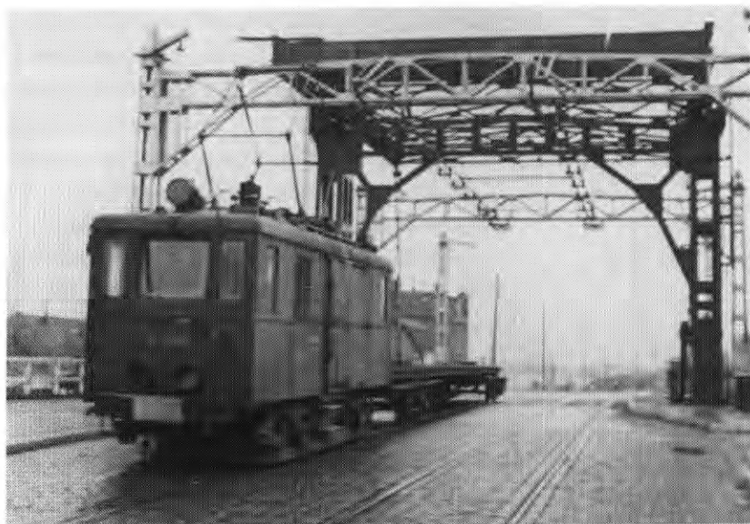
Een werkmotorwagen en raillorries op de brug over de Oude Rijn bij de Haagse Schouw. Materialen worden afgevoerd.
