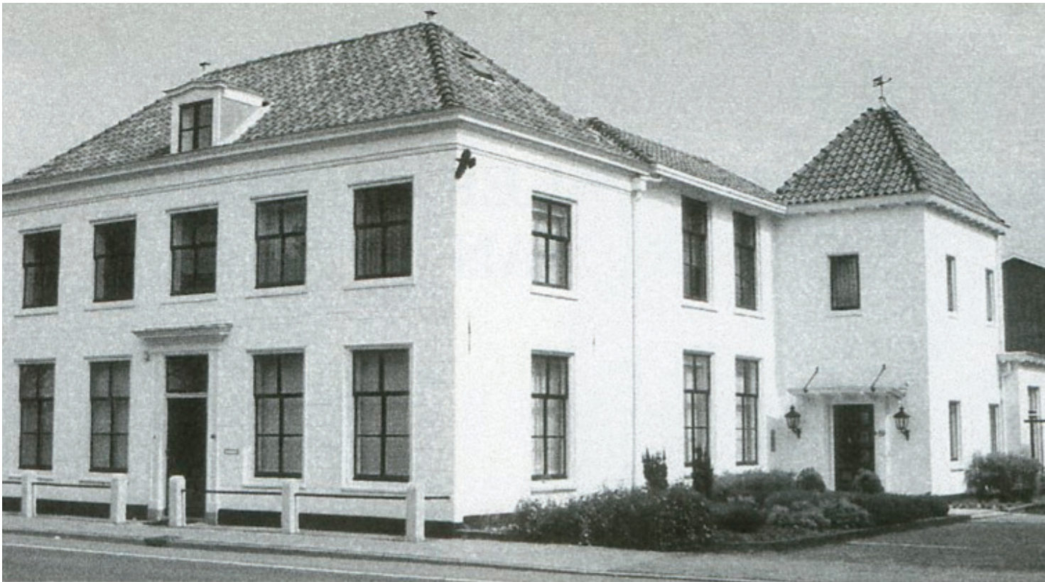
Afb. 2 Thans wordt het gehele pand Rhijngeesterstraatweg 60 (met 58) gebruikt door verschillende ondernemingen en bedrijven.
