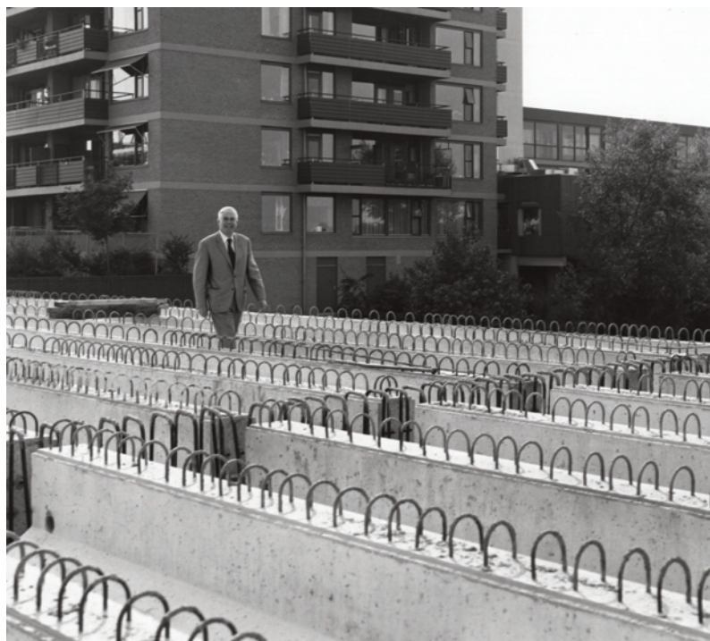
Burgemeester Van Eysinga op de Van Eysingabrug over het Oegstgeester Kanaal in aanbouw; op de achtergrond serviceflat Haeswijk, augustus 1979.
