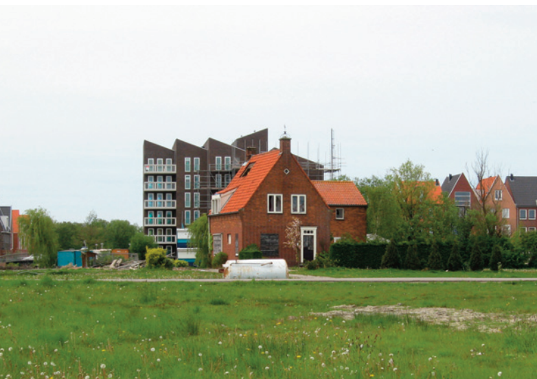
Pand aan de Rhijnhofweg, naderhand gesloopt in verband met de nieuwe wijk Nieuw-Rhijngest, met op de achtergrond nieuwgebouwde panden aan de Rijn in Valkenburg, 2010.
