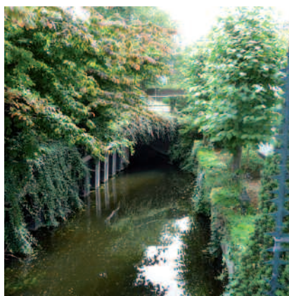
Afb. 18 De watering vlak voor het bruggetje bij de monding in het Oegstgeester Kanaal (2010).
