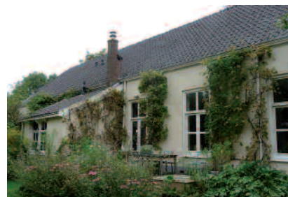
Afb. 8 Achterzijde, aan de waterkant, van landhuis De Grunerie, Van Cuycklaan.
